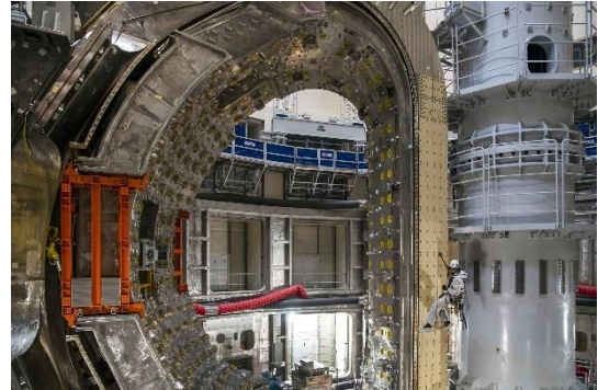
Anhang 2: Montage von Kammer-Modul in ITER (Quelle: iter.org)
